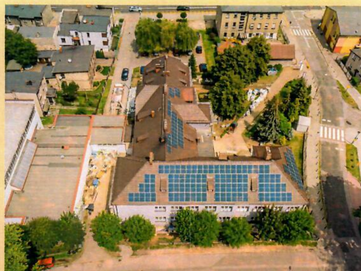
Termomodernizacja szkoły w Nakle Śl.
