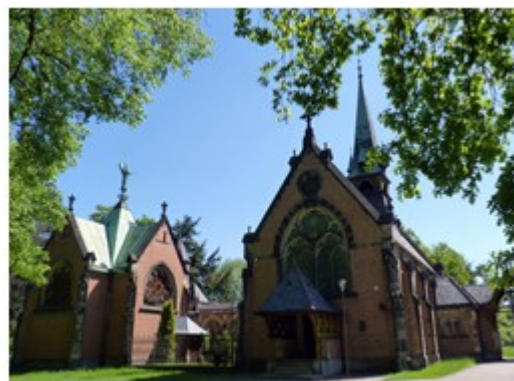
Fotografia 9. Widok na Zespół kaplicy mauzoleum w Świerkłańcu.
