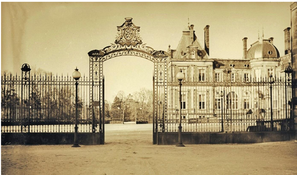
Rysunek 7 Fragment zabytkowego ogrodzenia na archiwalnym zdjęciu
